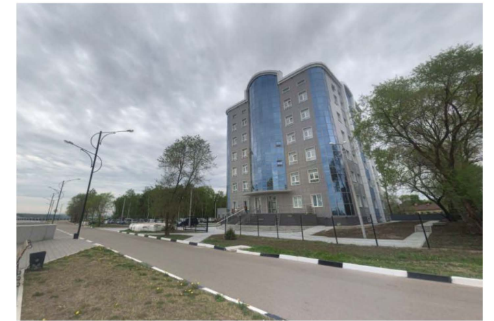
4 Федеральная сетевая компания Единой энергетической системы
