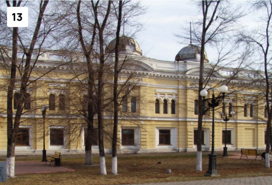
Чайная развесочная и розлив вин Торгового Дома «И. Я. Чурин и Ко» Построенное в 1910-е гг. кирпичное двухэтажное с подвалом, прямоугольное в плане здание расположено на красной линии площади Победы (ранее – территория Гостинодворского базара)
