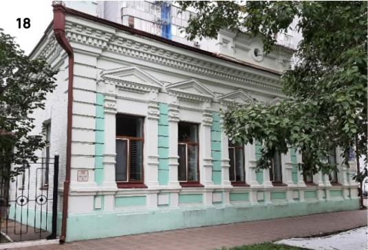
Бывший частный дом Лукина Здание построено в конце XIX – начале XX веков. В доме размещалась контора торгового дома «В. М. Лукина С-ья». После 1920 года в этом здании располагался дом ребенка, в настоящее время здесь расположено медицинское учреждение
