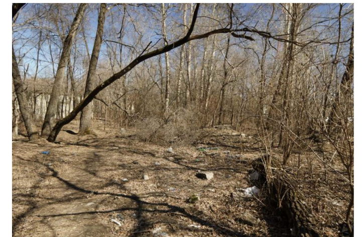
8 Оставленный строительный мусор, использование сквера как транзита строительной техники
