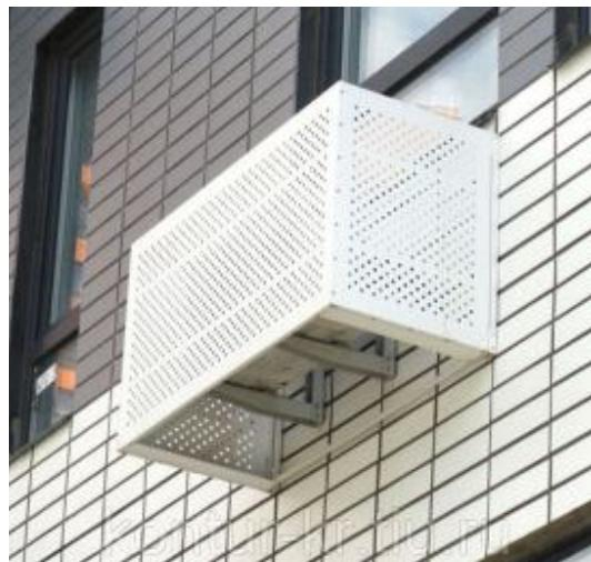
Пример конструкции декоративной корзины для внешнего блока кондиционера
